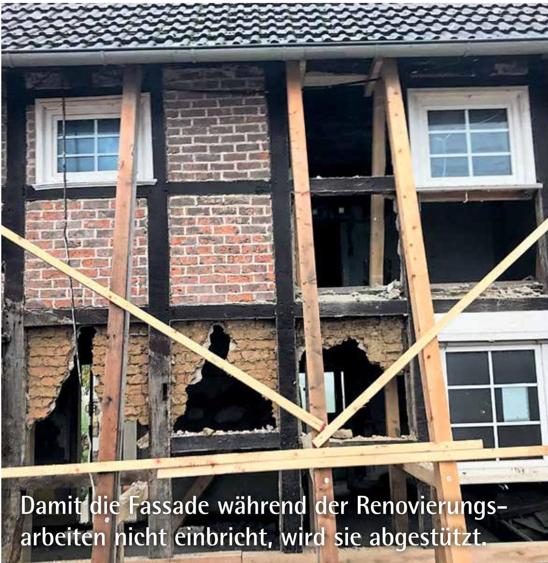
Damit die Fassade während der Renovierungsarbeiten nicht einbricht, wird sie abgestützt.
