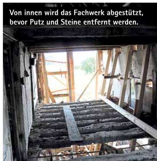
Von innen wird das Fachwerk abgestützt, bevor Putz und Steine entfernt werden.
