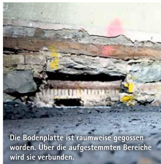
Die Bodenplatte ist raumweise gegossen worden. Über die aufgestemmt Bereiche wird sie verbunden.
