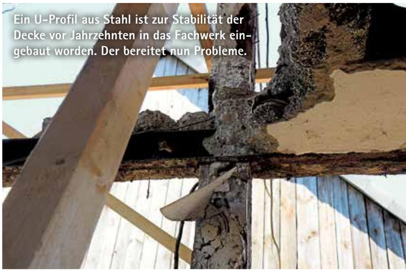
Ein U-Profil aus Stahl ist zur Stabilität der Decke vor Jahrzehnten in das Fachwerk eingebaut worden. Der bereitet nun Probleme.
